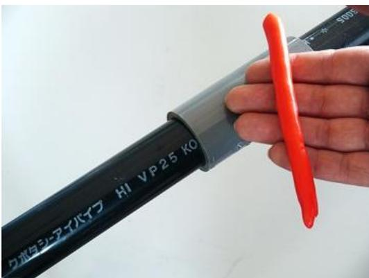
スムースを細く伸ばし、隙間へ充填して行きます。
