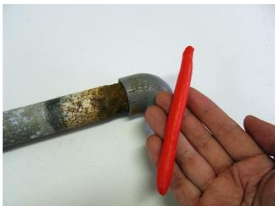
配管と継手の段差だけではなく、継手の上にもスムーズが乗る様になだらかに成型を行います。
