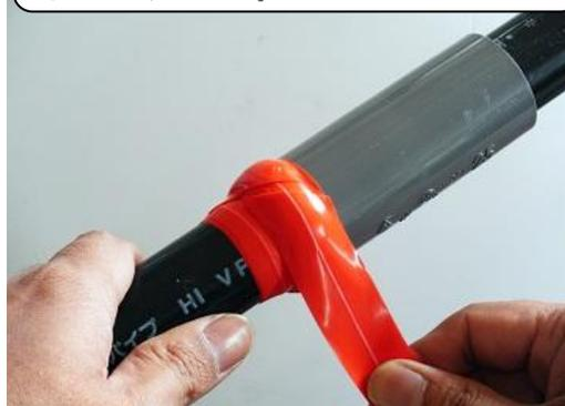
反対側へ移行する際、LLFA スムースを仮止めした中央部は軽く引っ張って巻きながら反対側へ移行し、移行後はテープの幅が通常の半分になるまで強く引っ張ったまま巻き付けてください。配管とテープの境目は2周以上巻きつけを行います。
