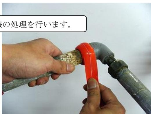
両端への締め付け処理が終わりましたら、LLFA スムースをしっかりと固定させるために、LLFA スムースの上に LLFA テープを巻きつけます。両端の処理同様に、LLFA テープの幅が半分になるまで強く引っ張ったままテープを巻き、LLFA スムースに圧力をかけ施工部の凹凸面に確実に密着させてください。
