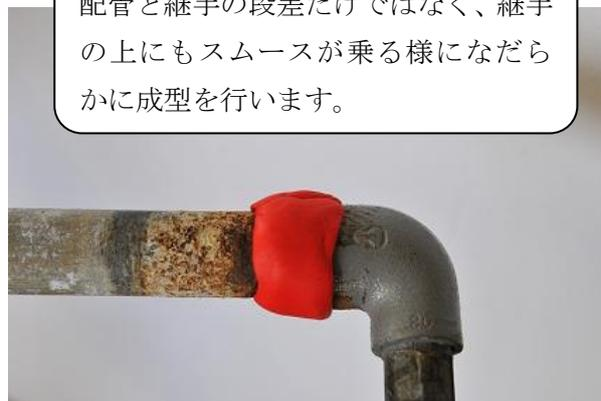
LLFA スムースを凹凸個所に充填後、配管にしっかりと密着させ隙間を生じないように、手のひらで『ギュッ』と押しつけて圧縮させてください。
